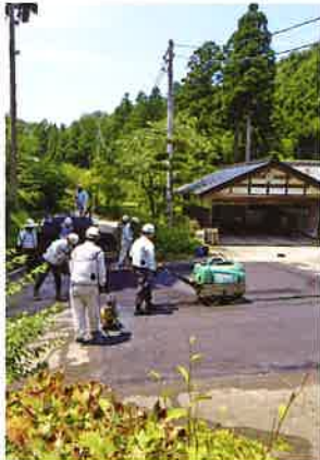
境内舗装工事、7月20日
