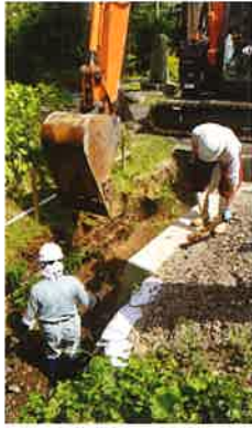
山田川改修工事 8月25日
