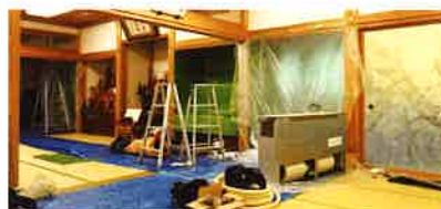
照光殿一回エアコン取替工事 6月15日前後
