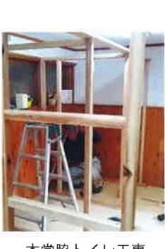
本堂脇トイレ工事
