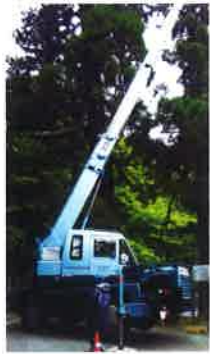
大杉枯れ枝処理工事
