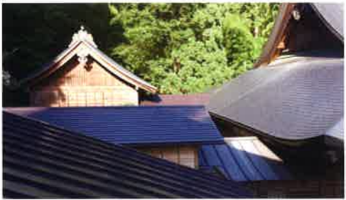
位牌堂への渡り廊下屋根工事 8月27日
