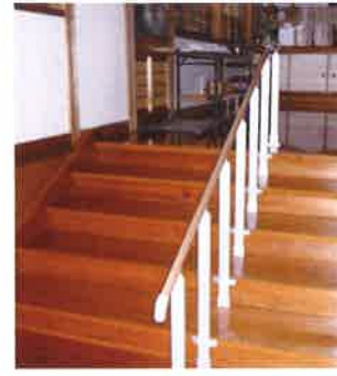
位牌堂に向う階段に付けられた手すり 9月30日
