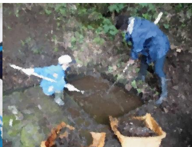
排水溝の泥上げ
