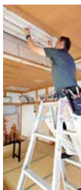
照光殿一階の 照明をLEDに 6月28日
