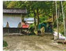
土蔵脇の竹藪を工事の為、整地 10月23日
