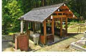
墓地東屋屋根改修工事 7月22日
