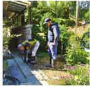
内玄関脇の上水道工事 6月20日
