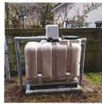
上水道工事、タンク設置 3月11日
