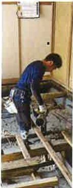
寺務所改修工事 7月11日
