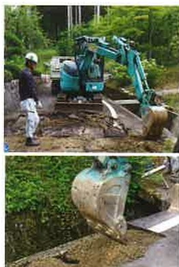
道路陥没箇所復旧工事 7月28日 (下：県が負担 7月29日)
